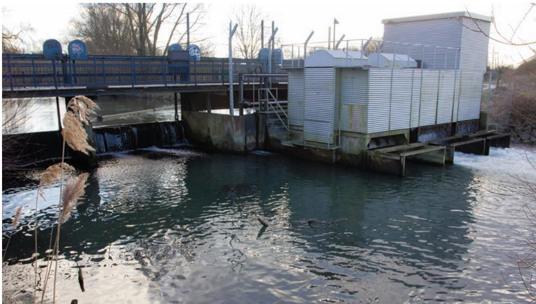
Abb. 169: Ableitungswehr Boker Heide mit Kleinwasserkraftanlage rechts
