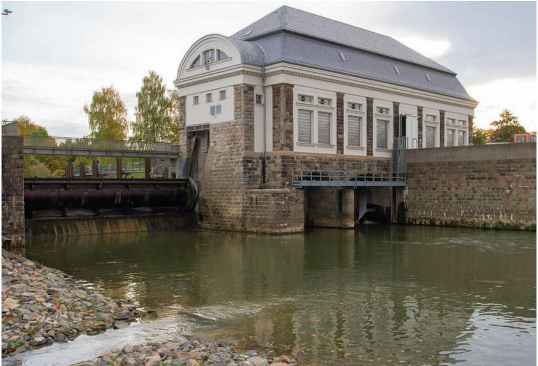
Abb. 167: Wehr Hamm: Im Vordergrund links der Einstieg des Umgehungsgerinnes, dahinter das geschlossene Walzenwehr; im von hier aus gesehen rechten Fach unter dem Gebäude befindet sich die Kleinwasserkraftanlage.
