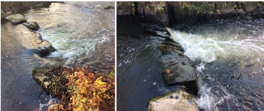
Abb. 42: Naturnaher Fischaufstieg am Wehr Buddenburg, Darstellung einzelner Steinriegel
