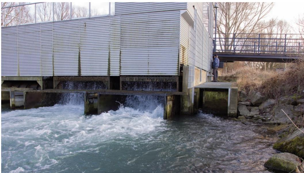
Abb. 170: Rechts neben der Wasserkraftanlage befindet sich der Einstieg des Fischweges, der nur von einer geringen Wassermenge durchflossen wird. Die Wange am Auslauf der Wasserkraftanlage lenkt Strömung und Fische vom Ufer und damit vom Aufstieg weg.
