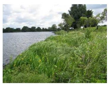
Vorgelagerter Wellenbrecher (Steinwalzen), dahinter Flachwasserzone; bepflanzt mit Röhrichtmatten, Entwicklung nach 2 Jahren
