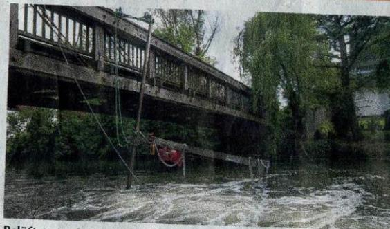
Belüftet: An der Elsemühle installierten Mitarbeiter des Wasserwerks eine Pumpe, die den Sauerstoffgehalt im Wasser erhöht.
