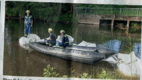
Abgedichtet: Das THW Bünde platzierte große Sandsäcke zur Sicherung des Altarms der Else in Kirchlhengern.
