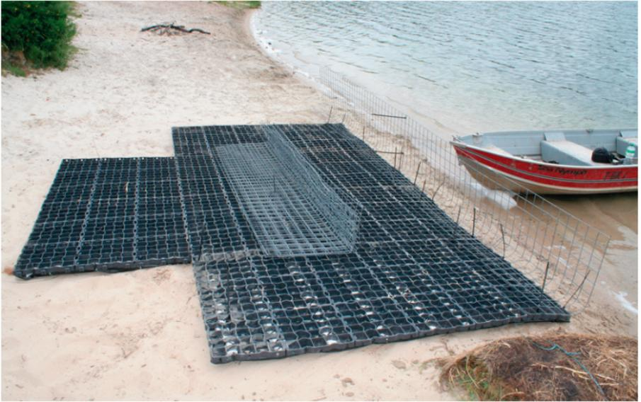
Fertige Schwimminsel in Element-Bauweise, gewinkelte Estrichmatten dienen als Ver-
