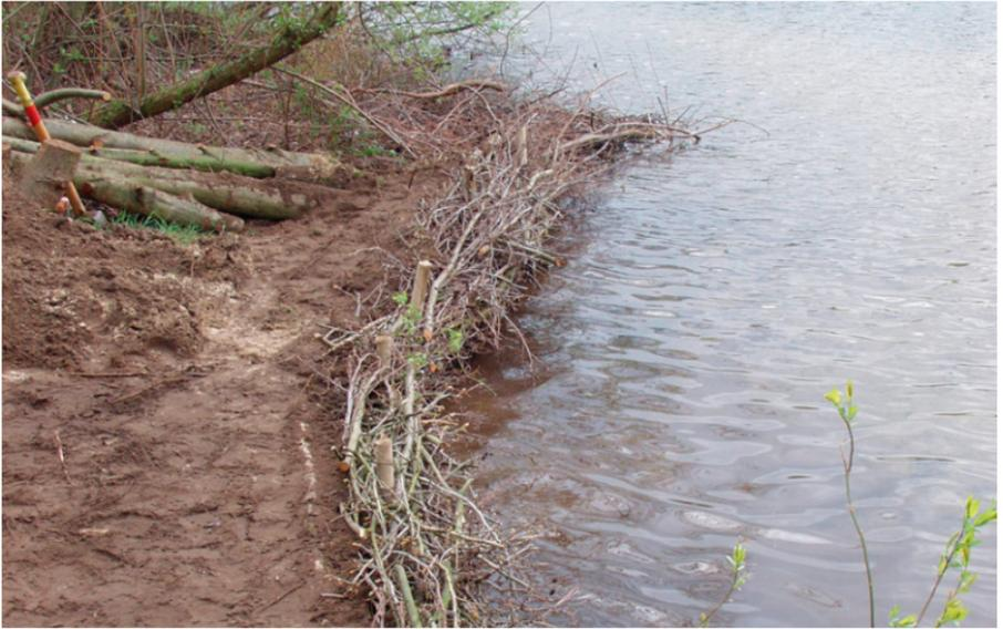
Faschine zur Uferbefestigung oder zur Vermeidung von Wellenschlag
